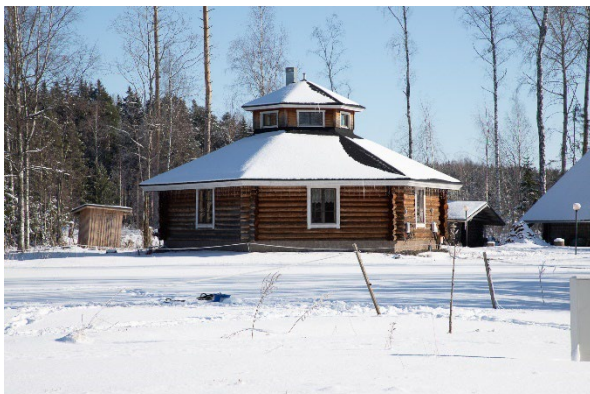
Juhla-/kokoustila on rakennettu vuonna 2001. Käytetty rakennusoikeus on 90 kem 2 .
